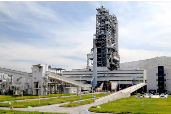
八一钢铁富氢碳循环高炉建设项目
