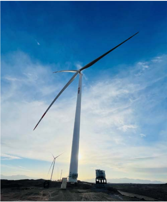
中国西电集团所属西安西电新能源有限公司宁夏吴忠市利通区扁担沟镇五里坡分散式风电项目
