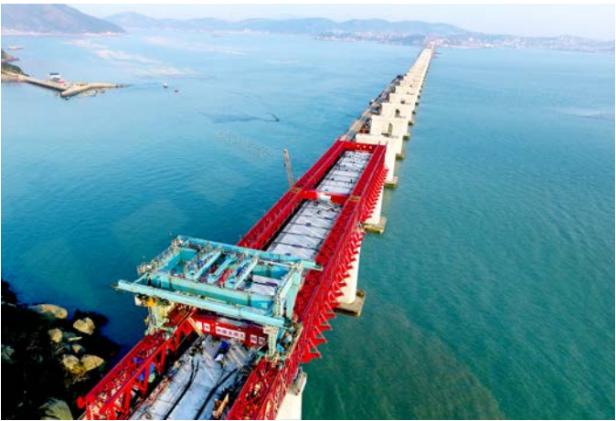
平潭海峡公铁两用大桥
