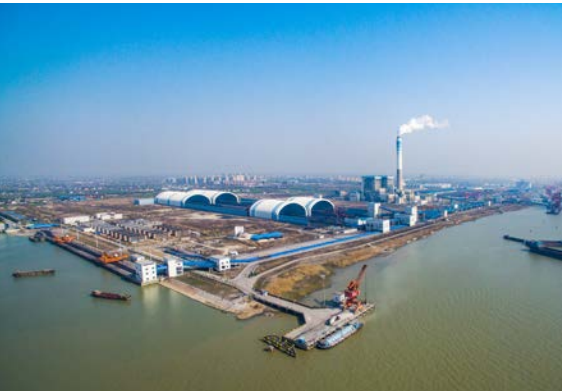
国信靖江电厂运行 2 台 660MW 超超临界燃煤发电机组，2021 年完成发电量 70 亿千瓦时，同比增长 12%
