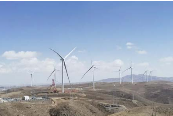
京能靖远 100MW 风电项目
