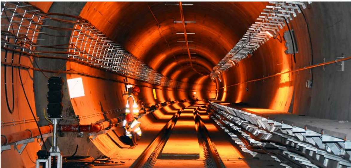
成都轨道交通 18 号线隧道施工现场
