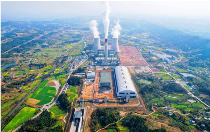
四川天明超临界百万千瓦火电机组项目航拍全景
