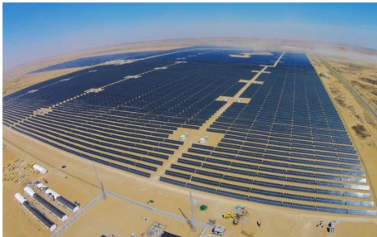
中电投达茂旗 20 兆瓦光伏项目
