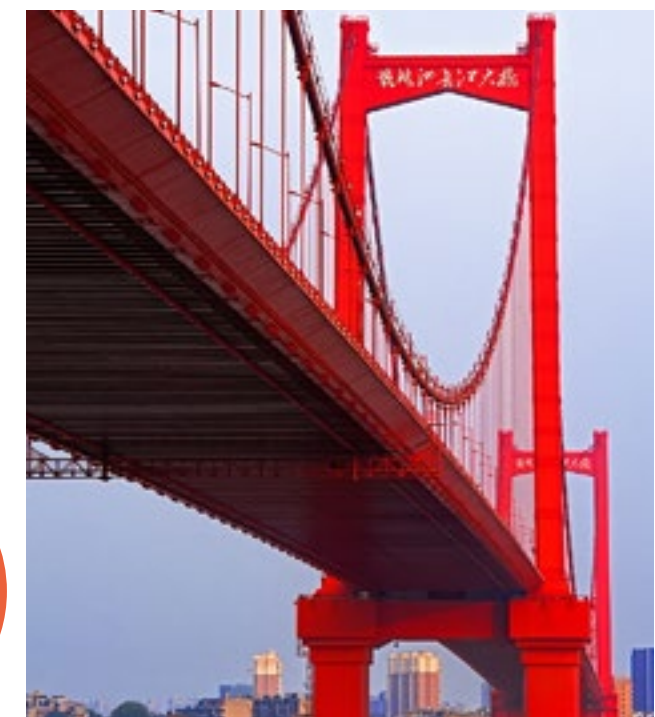
武钢建工集团承建的武汉市鹦鹉洲长江大桥两岸接线工程
