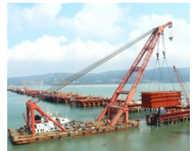
中国铁建财务公司支持大桥局攻克国内首座跨海高铁两用桥关键技术难关
