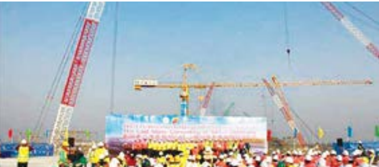
2019 年 1 月 28 日 中国建筑工程（泰国）有限公司在泰国曼谷的泰国素万那普机场举行提前封顶仪式
