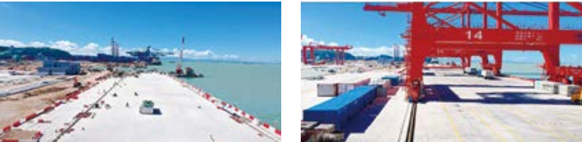
• 深圳海星港口发展有限公司海星集装箱智慧港口建设现场（广东深圳）
